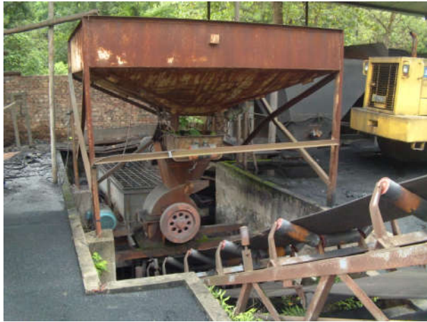
图 1-3 破碎机及配煤机现状图
