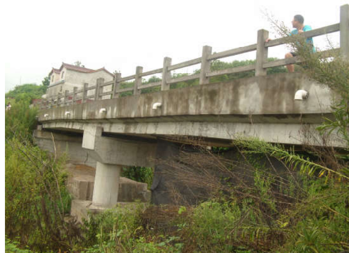
图 1-2 项目桥梁部分现状图 2
