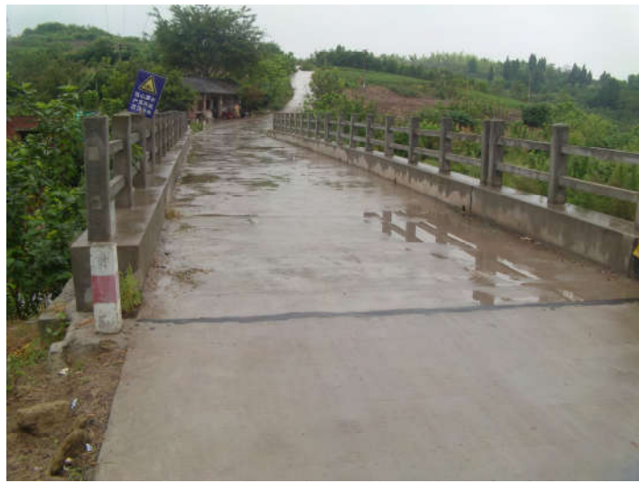
图 1-1 项目桥梁部分现状图 1
