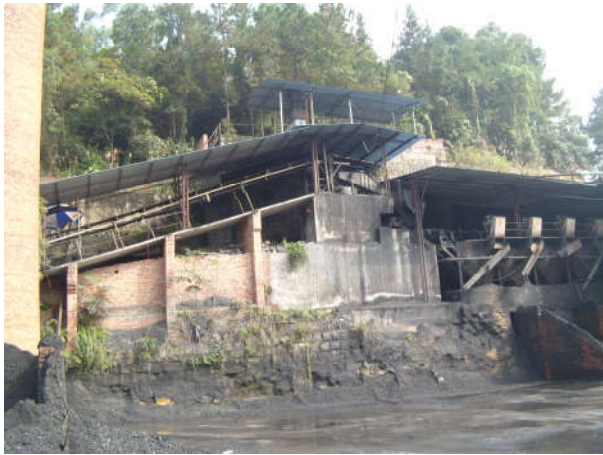
图 1-3 原煤传输系统及筛分破碎车间现状图
