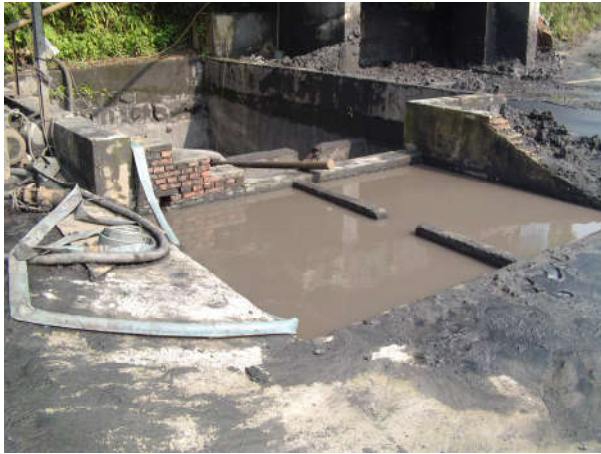
图 1-5 项目沉淀池现状图
