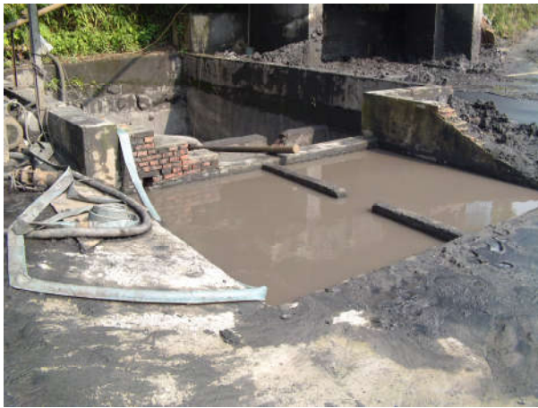
图 1-5 项目沉淀池现状图
